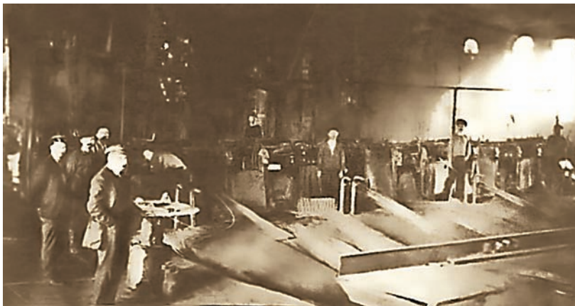
На Дніпровському металургійному заводі. Початок ХХ ст.
